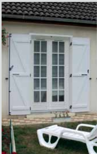
LE FERRAGE STANDARD Pose sur gonds neufs, Gonds fournis et pentures posées aux côtes standards
