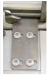
Vérouillage mécanique du portillon dès que la porte de garage s'ouvre
