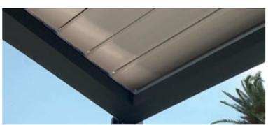
Aspect toit plat sous la pergola avec lames inclinées pour un meilleur écoulement des eaux
